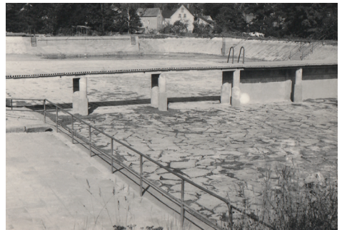
Der Bau war weit gediehen
