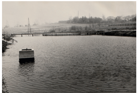
Und Wasser kam auch noch rein!
