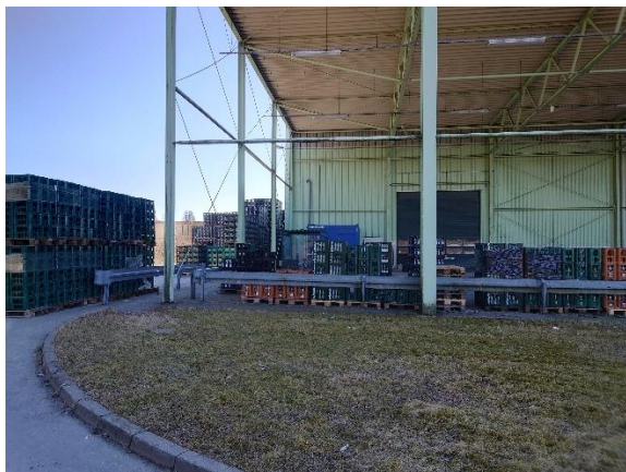
Seitlichen Blick in der Ladestraße mit links im Bild Lagerflächen. Nördlicher Bereich des Firmengeländes, Blickrichtung Süd.
