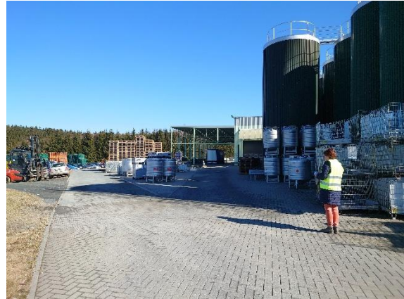
Ladestraße (Bildmitte) und Silos bzw. Wassertanks (rechts) im nördlichen Bereich des Geländes, Blickrichtung Ost.
