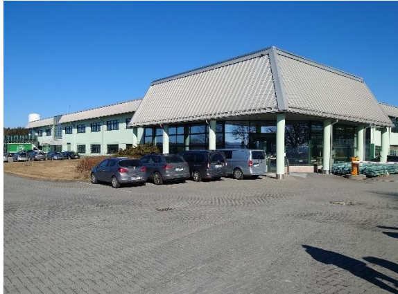
Blick von der Einfahrt des Firmengeländes an der Sprudelstraße (K 7846) ri. Norden zum Haupteingang der Bad Brambacher Mineralquellen GmbH & Co. Betriebs KG.
